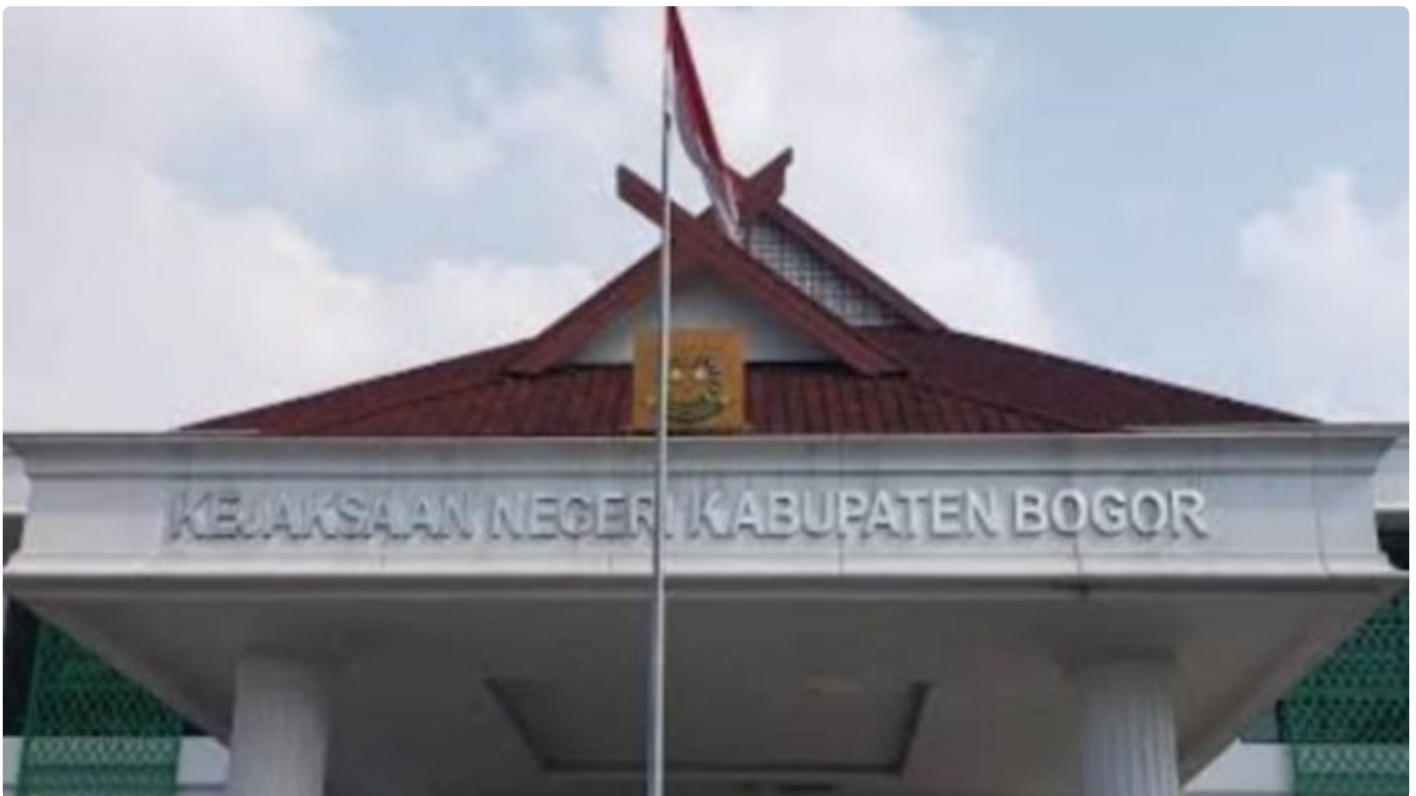
Photo : Gedung Kejari Kabupaten Bogor
